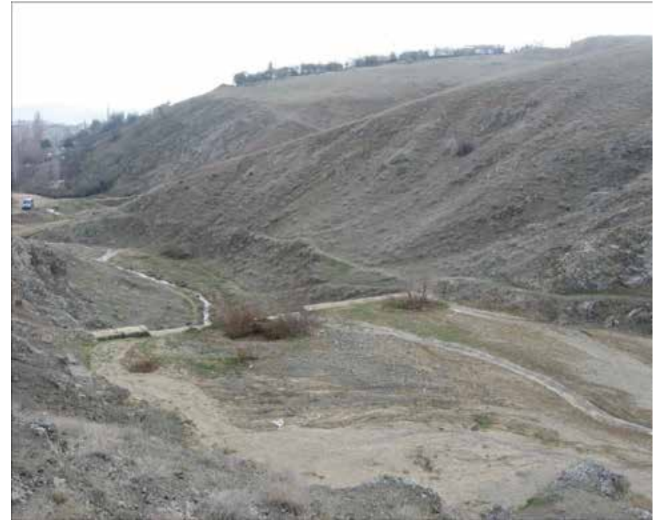
Foto 13. Esentepe mahallesinin batısında vadi içine yapılan bent ve gerisinde meydana gelen siltasyon
