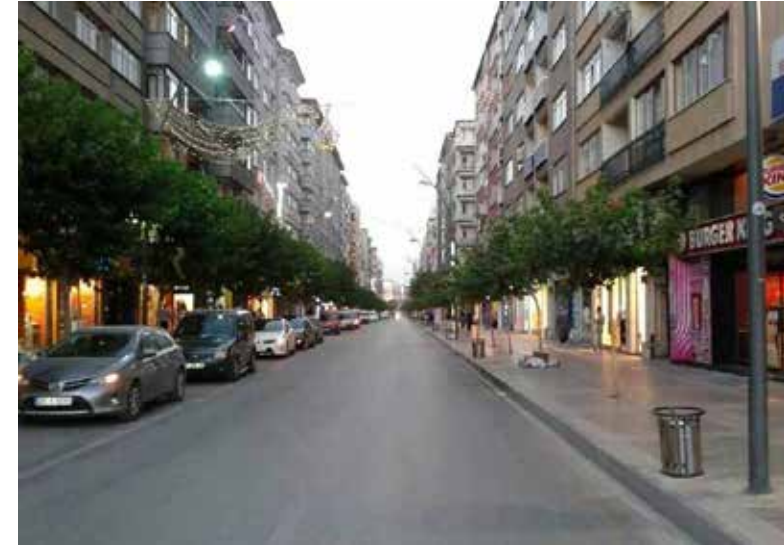
Foto 5. Elazığ Gazi Caddesinde binaların oluşturduğu şehir kanyonu
