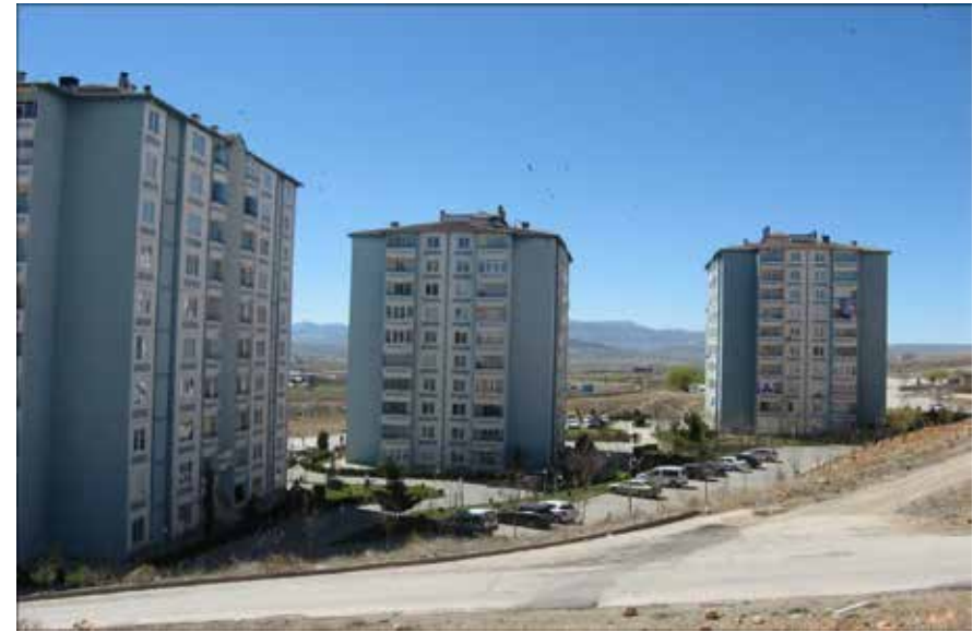
Foto 8. Elazığ Hilalkent mahallesinde oluşan basamaklar
