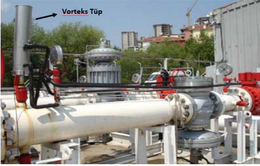
Şekil 6: Vorteks Isıtıcı Montajı Yapılmış Doğalgaz Hattı (Özbudaklar 2024)
