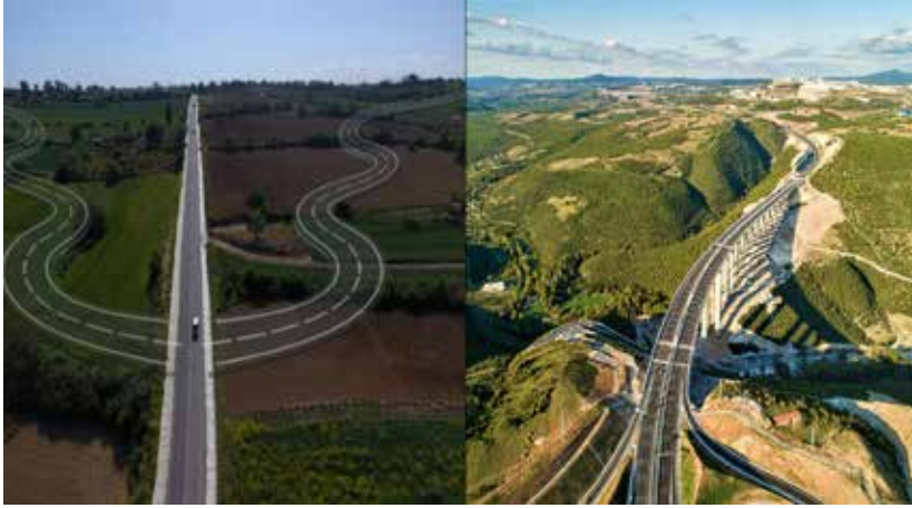
Foto 1. MOR güzergahının farklı karayolu bölümlerinin insansız hava aracı (İHA) görüntüleri. Sol kısımda yapılması planlanan karayolu bölümünün görüntüsü yer alırken sağ fotoğrafta yapılmış karayolu bölümü görülmektedir.
