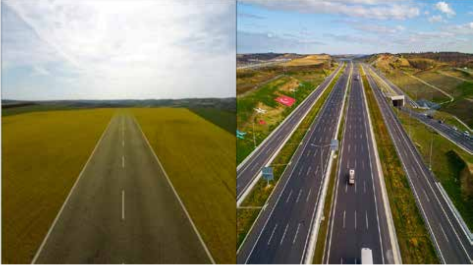
Foto 3. MOR güzergahının farklı karayolu bölümlerinin insansız hava aracı (İHA) görüntüleri. Sol kısımda yapılması planlanan karayolu bölümünün görüntüsü yer alırken sağ fotoğrafta yapılmış karayolu bölümü görülmektedir.
