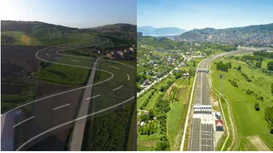
Foto 4. MOR güzergahının farklı karayolu bölümlerinin insansız hava aracı (İHA) görüntüleri. Sol kısımda yapılması planlanan karayolu bölümünün görüntüsü yer alırken sağ fotoğrafta yapılmış karayolu bölümü görülmektedir.
