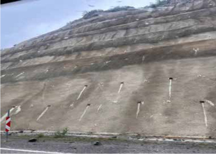
Foto 2. Zemin çivisi ve püskürtme beton ile güçlendirilmiş şev yüzeyi.
