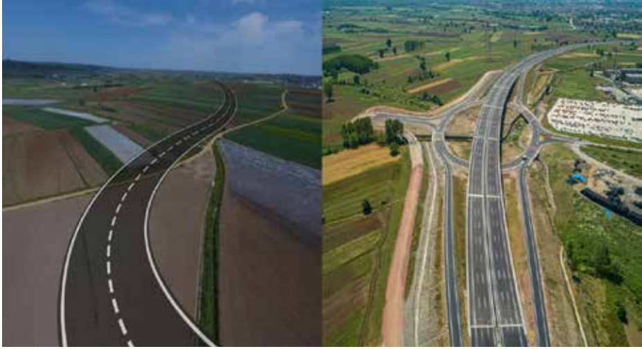
Foto 2. MOR güzergahının farklı karayolu bölümlerinin insansız hava aracı (İHA) görüntüleri. Sol kısımda yapılması planlanan karayolu bölümünün görüntüsü yer alırken sağ fotoğrafta yapılmış karayolu bölümü görülmektedir.
